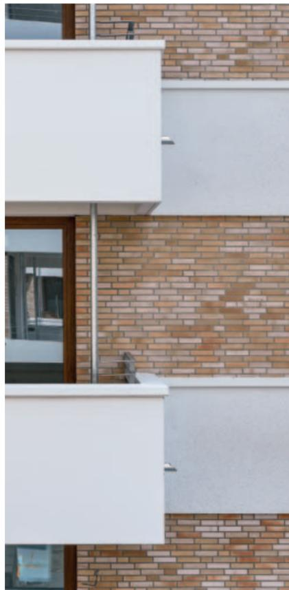
Die Balkone aus Betonfertigteilen führen die Akzentuierung durch die Gesimsbänder fort
