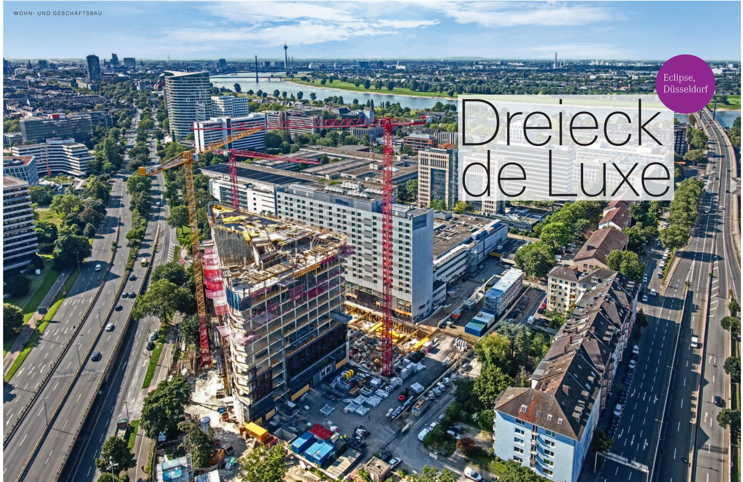
*Rohbauauftrag der Superlative: Das Eclipse in Düsseldorf wird auf dem 8.722 m<sup>2</sup> großen Grundstück 16 Vollgeschosse mit einer Nutzfläche von circa 35.000 m<sup>2</sup> bieten. Das angrenzende Hilton Hotel wurde für den Bau an der Längsseite durch eine tangierende Bohrpfehlwand gesichert, bestehend aus 90 Pfählen mit einer Tiefe von 12,5 beziehungsweise 16,3 m und einem Durchmesser von je 120 cm.*
