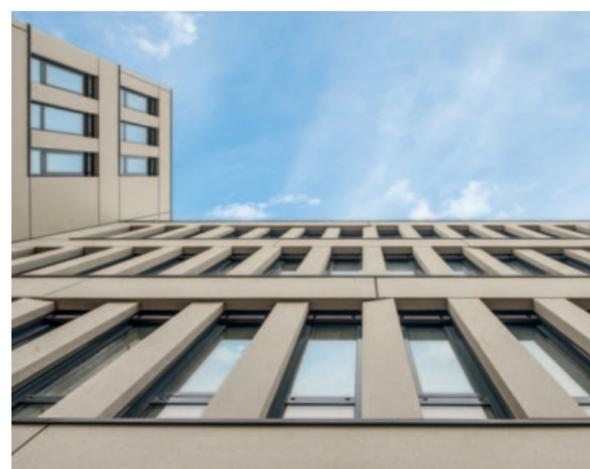
Mal bündig mit der Vorderkante der Riegel, mal zurückgesetzt, mal schräg gestellt: Die Anordnung der Stützen erzeugt eine Wellenstruktur
